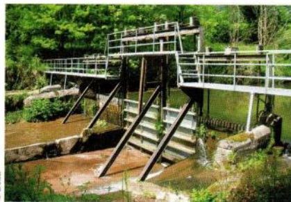
Le barrage de la centrale hydraulique de 200 kW à Moyennoutier (88).
